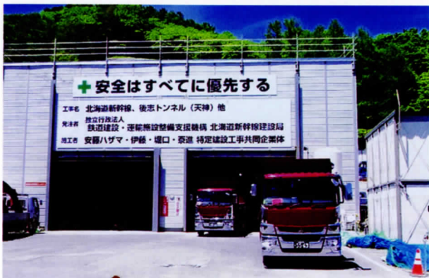
2030年/令和12年度末 北海道新幹線・小樽・札幌開業予定の奥沢・後志トンネル（天神）
